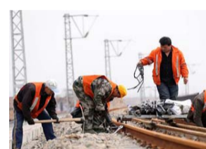
黄韩侯铁路侯西段电气化复线施工进度顺利
